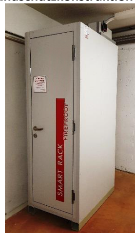
IT-Serverschutzschrank Brandschutzkonstruktion EI90
