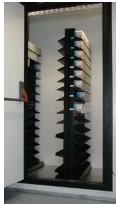
IT-Sicherheitszelle mit Stretch-Rack
